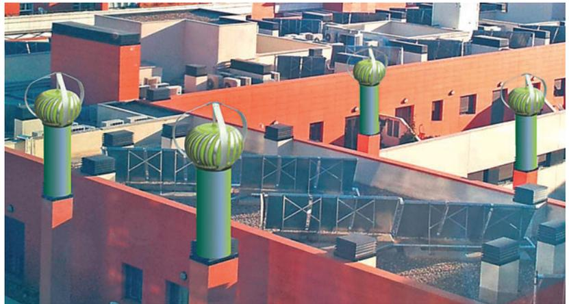
**Figura 6.** Imagen virtual con extractores eólicos instalados en azoteas.
