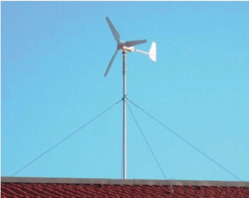
**Figura 2.** Aerogenerador montado sobre torre atirantada. Fuente: Garbitek.
