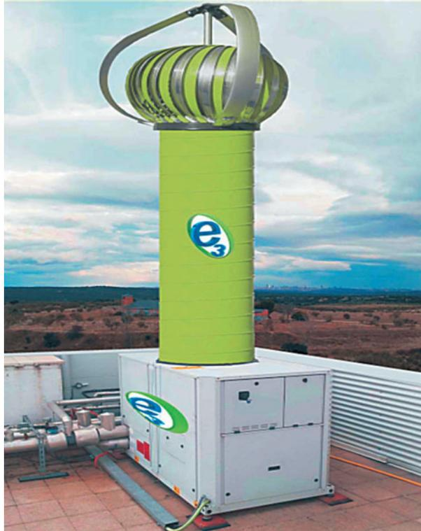
**Figura 4.** Sistema de ventilación con extractor eólico.
