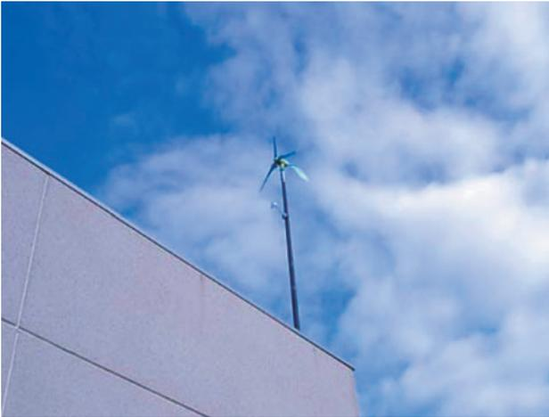
**Figura 1.** Aerogenerador Bornay instalado en cubierta de edificio.
