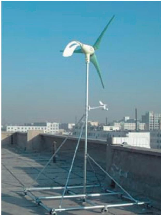
**Figura 4.** Aerogenerador Airdolphin de 1 kW instalado en techo de edificio.
