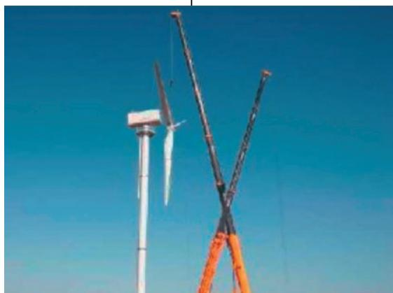
**Figura 15.** Montaje. Fuente: Electricia.
