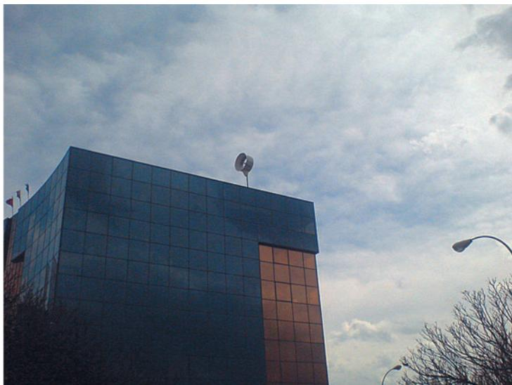
**Figura 3.** Aerogenerador Donqi 1.75 kW (2 m diámetro) instalado en cubierta de edificio en Pamplona. Fuente: CIEMAT.
