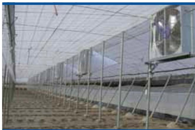
Foto 25. Grupo de extractores instalados en un invernadero de tipo Almería
