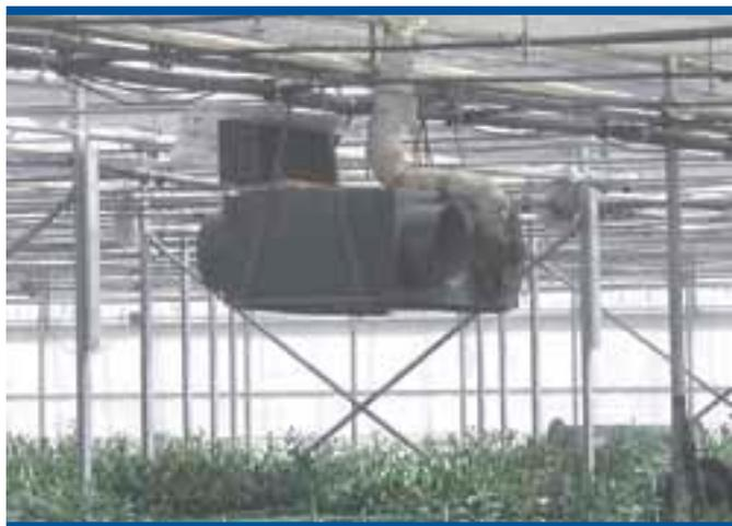
Foto 2. Generadores de calor por combustión indirecta
