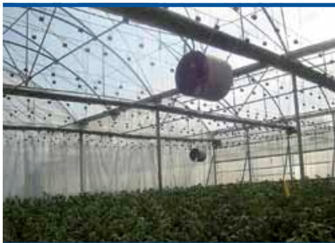
Foto 18. Ventilador para movimiento horizontal del aire dentro de un invernadero
