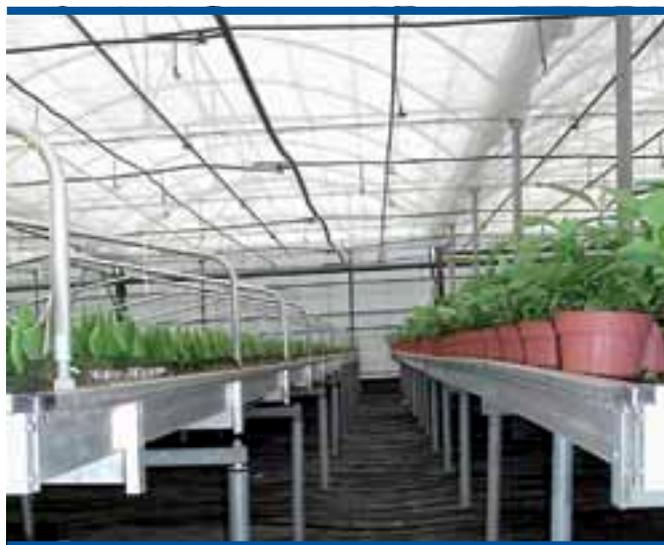
Foto 17. Tuberías de calefacción instaladas bajo las mesas de cultivo
