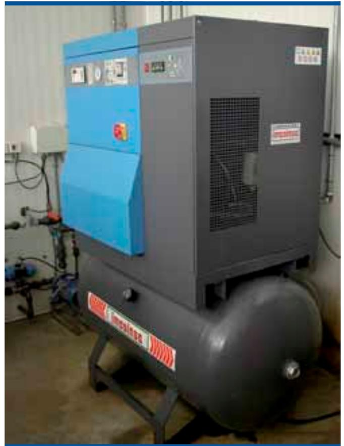
Foto 26. Compresor de aire y bomba de impulsión del agua en una instalación de nebulización
