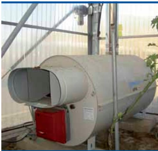
Foto 22. Intercambiadores de calor en un generador de aire caliente de combustión indirecta en un invernadero
