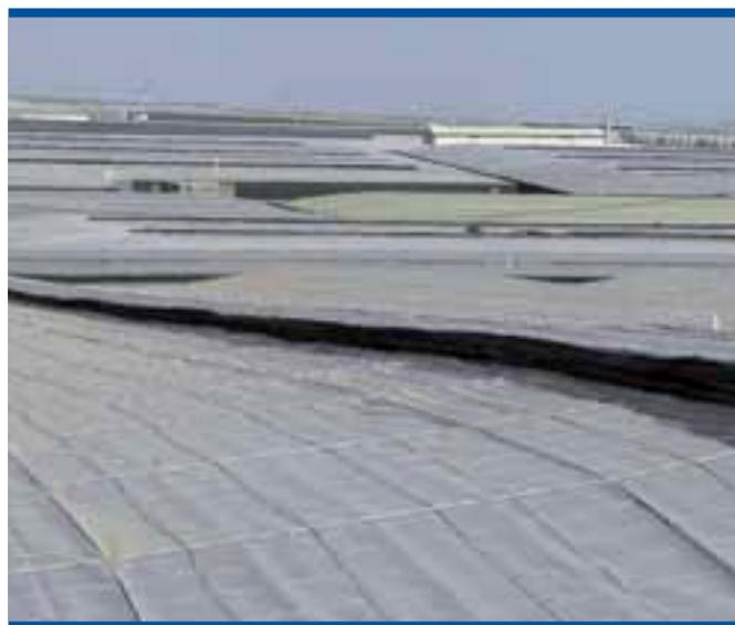
Foto 24. Aberturas cenitales de ventilación en un invernadero de tipo Almería cubiertas por malla anti-insectos
