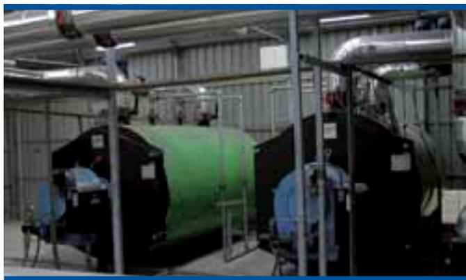
Foto 20. Instalación de calefacción en un invernadero con dos calderas para generación de agua caliente
