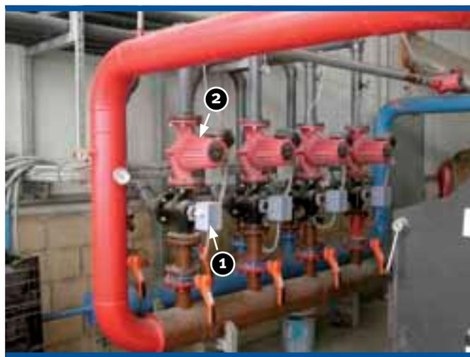
Foto 4. Instalación de calefacción por agua con válvulas de tres vías (1) y bombas de caudal regulable (2)
