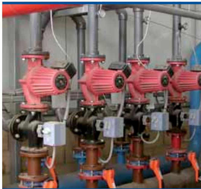
Foto 19. Bombas de impulsión de caudal variable para la distribución del agua de calefacción en invernaderos
