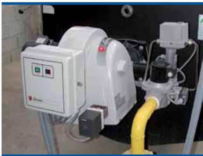
Foto 14. Quemador modulante en una caldera para calefacción de invernaderos
