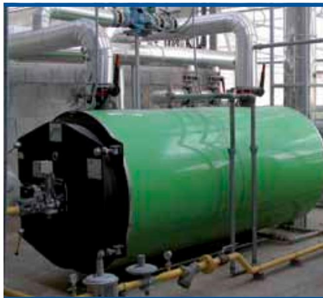
Foto 15. Aislamiento de la caldera y de las tuberías de calefacción mediante coquillas
