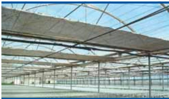
Foto 9. Invernadero con pantallas térmicas aluminizadas
