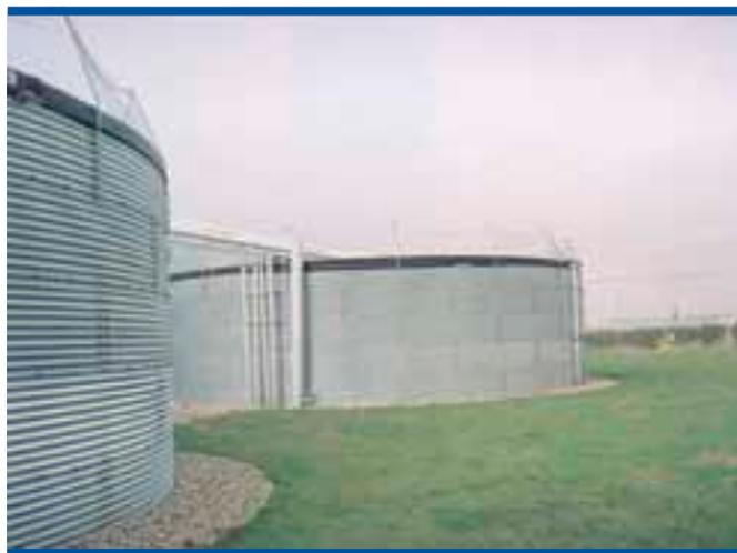
Foto 21. Depósito calorifugado para el almacenamiento de agua caliente para calefacción de invernaderos
