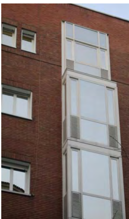
Foto 8. Cerramientos orientados al Este acristalados con vidrio de control solar.
