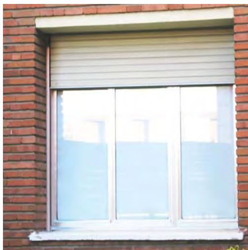
Foto 13. Carpintería metálica de aluminio con vidrio monolítico.
