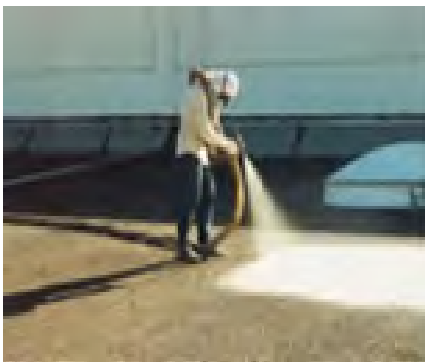
Foto 3. Rehabilitación de la cubierta con proyección de espuma de poliuretano.
