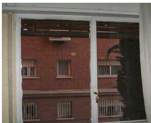
Foto 12. Carpintería metálica “acero Mondragón” con vidrio monolítico.
