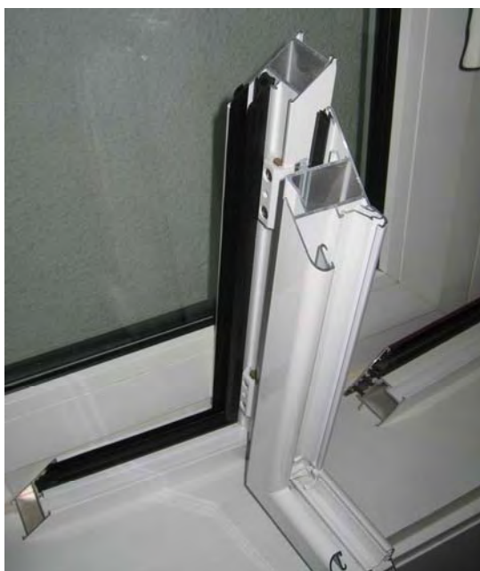
Foto 3. Carpintería metálica. Sección característica.
