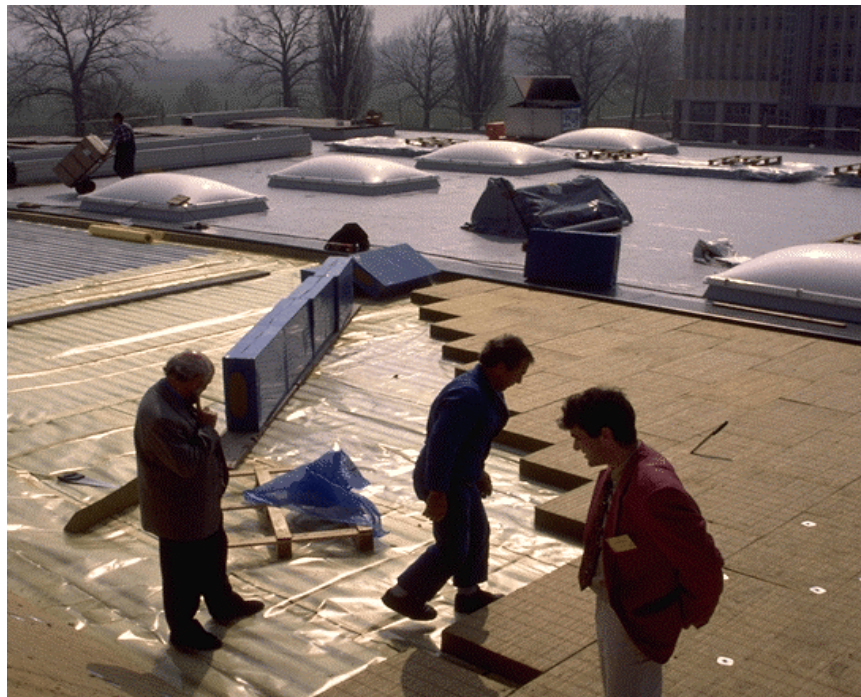
Foto 2. Cubiertas con fijación mecánica.
