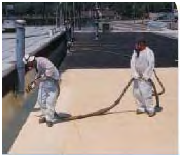
Foto 3. Rehabilitación de la cubierta con proyección de espuma de poliuretano.
