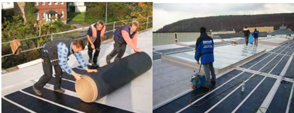
Figura 7. Montaje de los módulos-PV.
