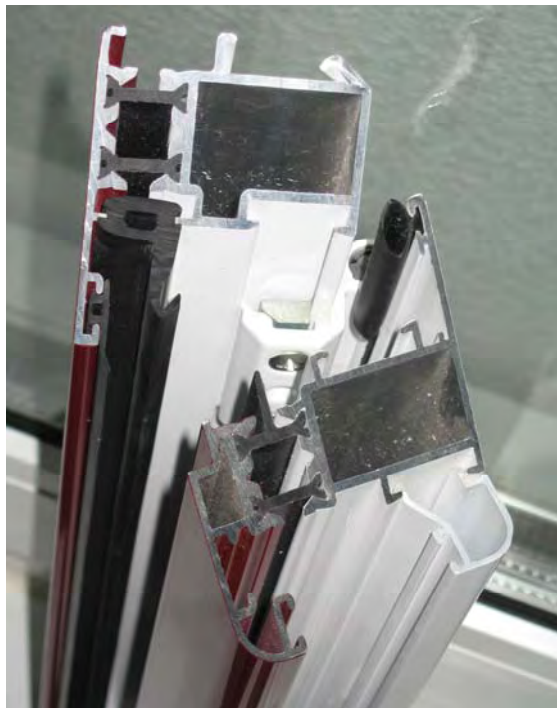
Foto 4. Carpintería metálica RPT. Sección característica.
