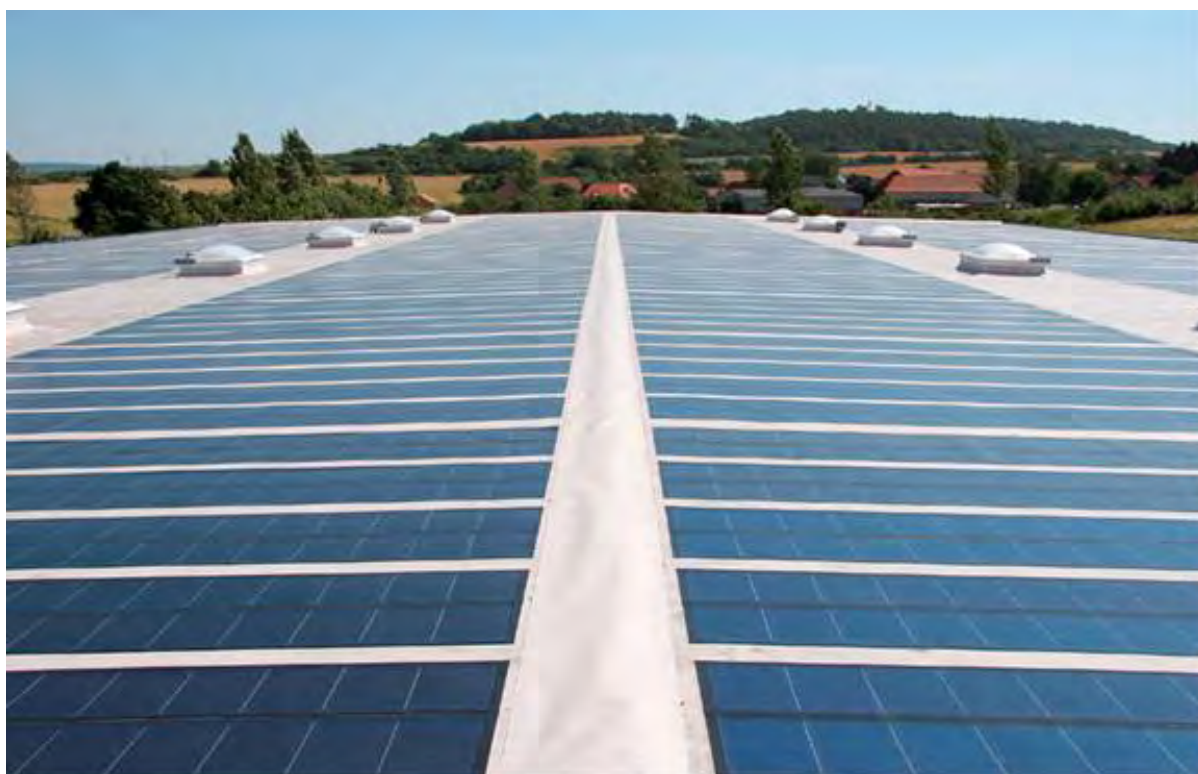
Foto 1. Cubierta solar terminada.
