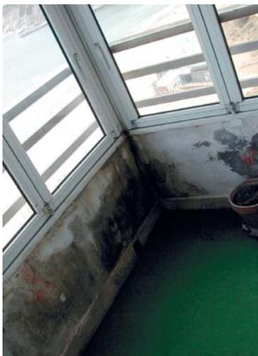
**Fotografía 2.** Efectos de condensación en puentes térmicos.
