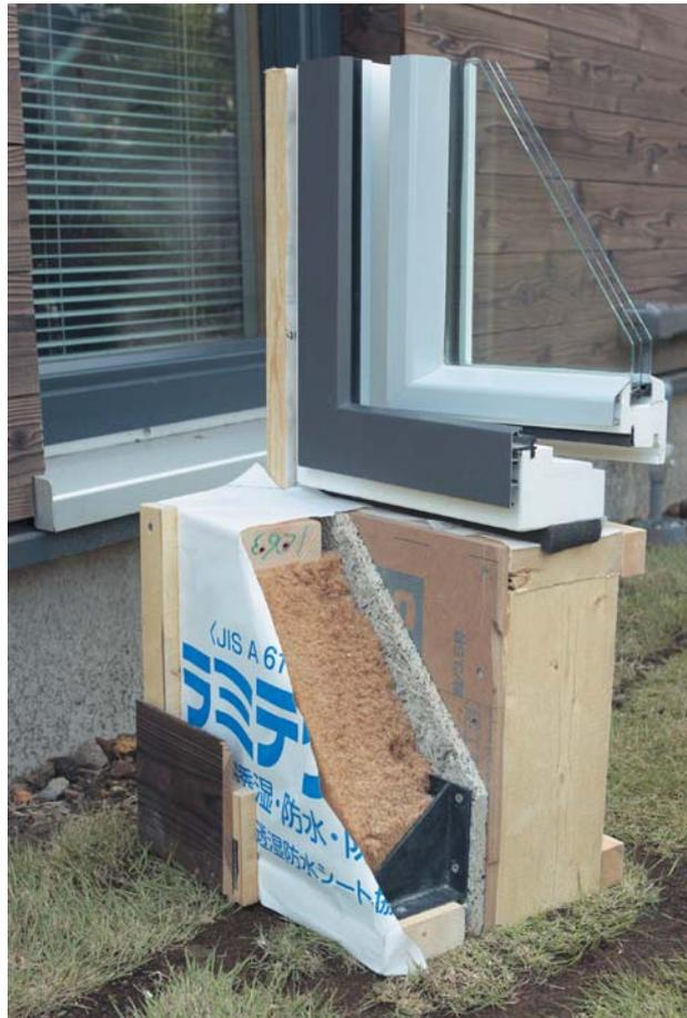
Fotografía 5. Maqueta sección pared y detalle ventana.
