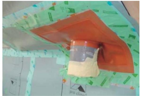
**Fotografías 15 y 16.** (Izq.) Paso de un tubo de ventilación en la cubierta.
