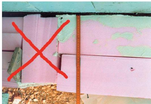
**Fotografía 1.** Ejemplo de aislamiento MAL ejecutado y de comprobaciones en obra del aislante térmico de perímetro de fachada.
