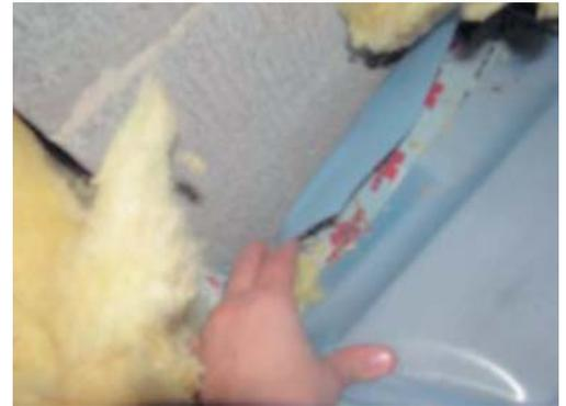
**Fotografías 1 y 2.** (izq.) Infiltración debido a penetración de cables. (drcha.) Infiltración debido a aislamiento incorrecto en el encuentro con la chimenea. (Fuente: Blower Door GmbH).
