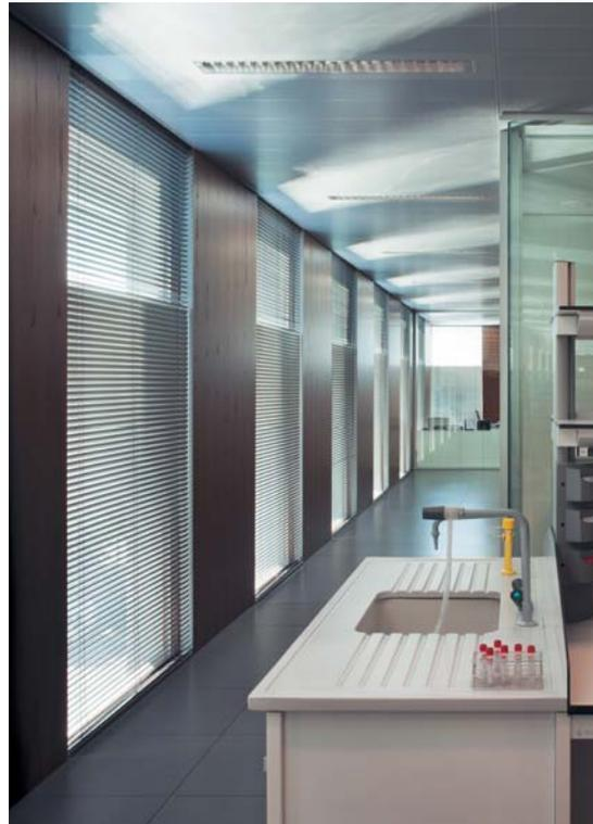
**Fotografía 1.** Protecciones interiores en el Banc de Sang i Teixits de Barcelona. Tanto los vidrios como las lamas interiores son reflectantes en su cara exterior. Las lamas disponen de doble inclinación para permitir la iluminación natural sin producir deslumbramientos ni sobrecalentamientos.
