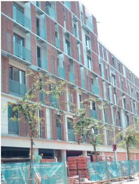
**Fotografía 2.** Protecciones solares móviles en un edificio de viviendas en Barcelona. Arquitectos: J. Sabaté y N. Ayza.
