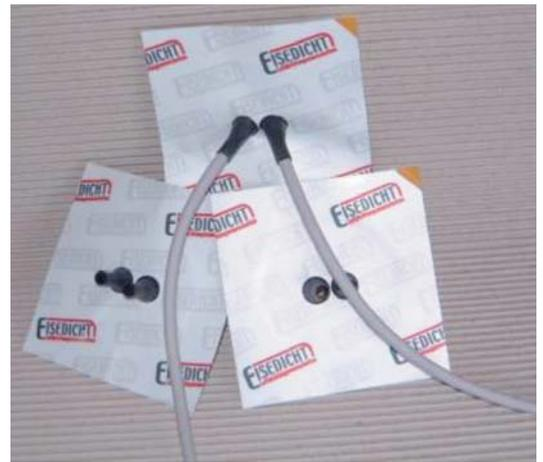
**Fotografías 13 y 14.** (Izq.) Paso de cables en la cubierta.
