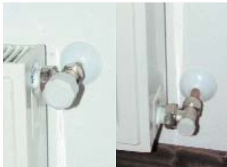
Radiador con conexión bitubo, con llave de corte en la parte superior (entrada) y detentor de reglaje en la parte inferior (salida)
