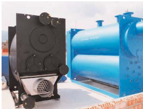
Caldera de condensación y de baja temperatura en fase de montaje
