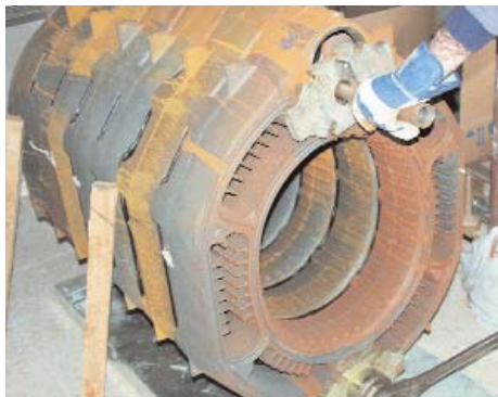
Caldera de elementos de hierro fundido que permite su montaje “in situ”, facilitando el traslado de la sala de calderas a la cubierta del edificio.
