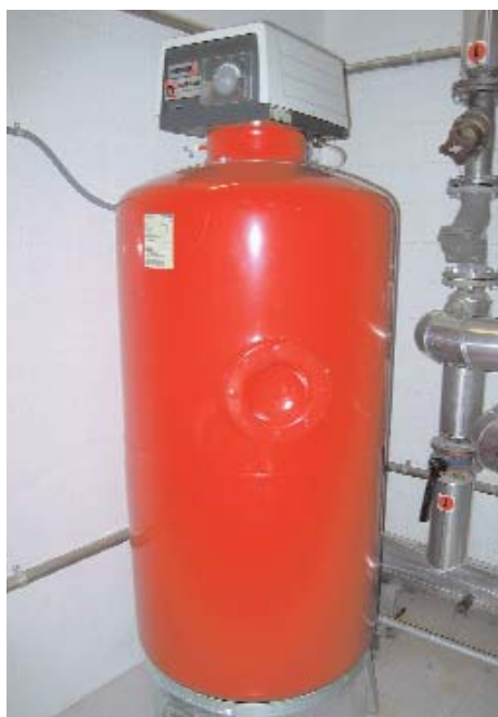
Vaso de expansión cerrado con compresor.
