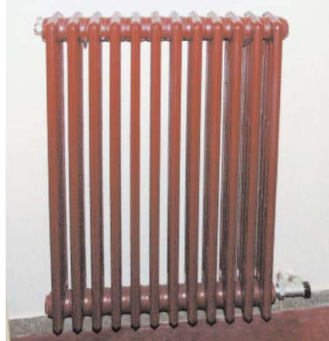
Figura 6. Elementos que constituyen un radiador.
