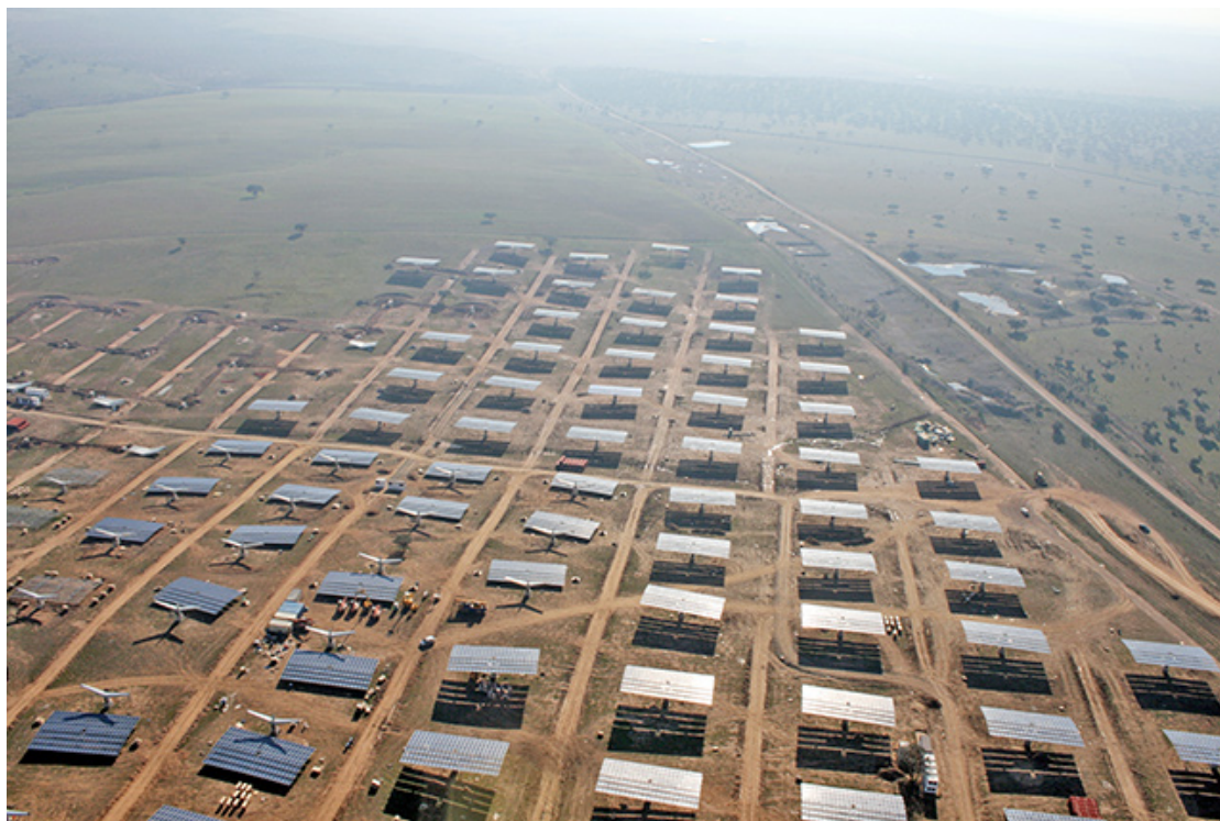
Fig. 4. Planta fotovoltaica de Hinojosa del Valle en período de obra.
