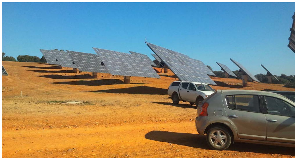
Fig. 1. Planta fotovoltaica el Ariero.
